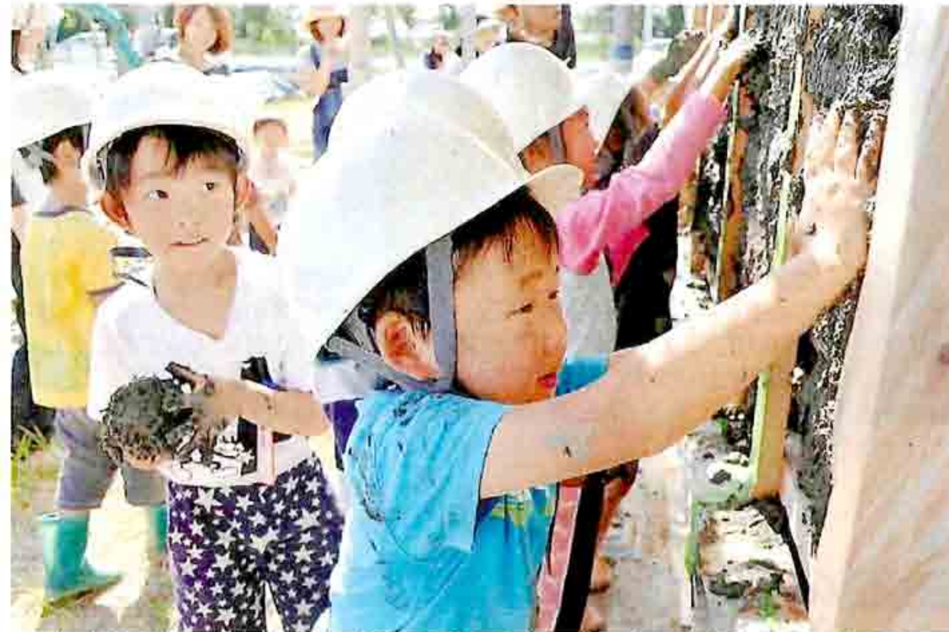
土を柱の隙間に力強く練り込む子どもたち—佐賀市の久保泉第2工業団地
